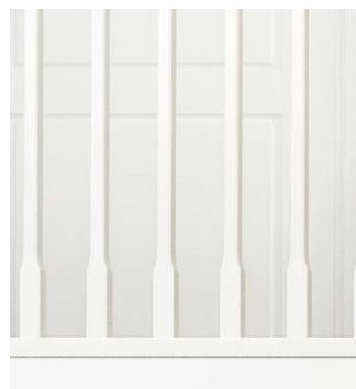
Montering i underliggeren
